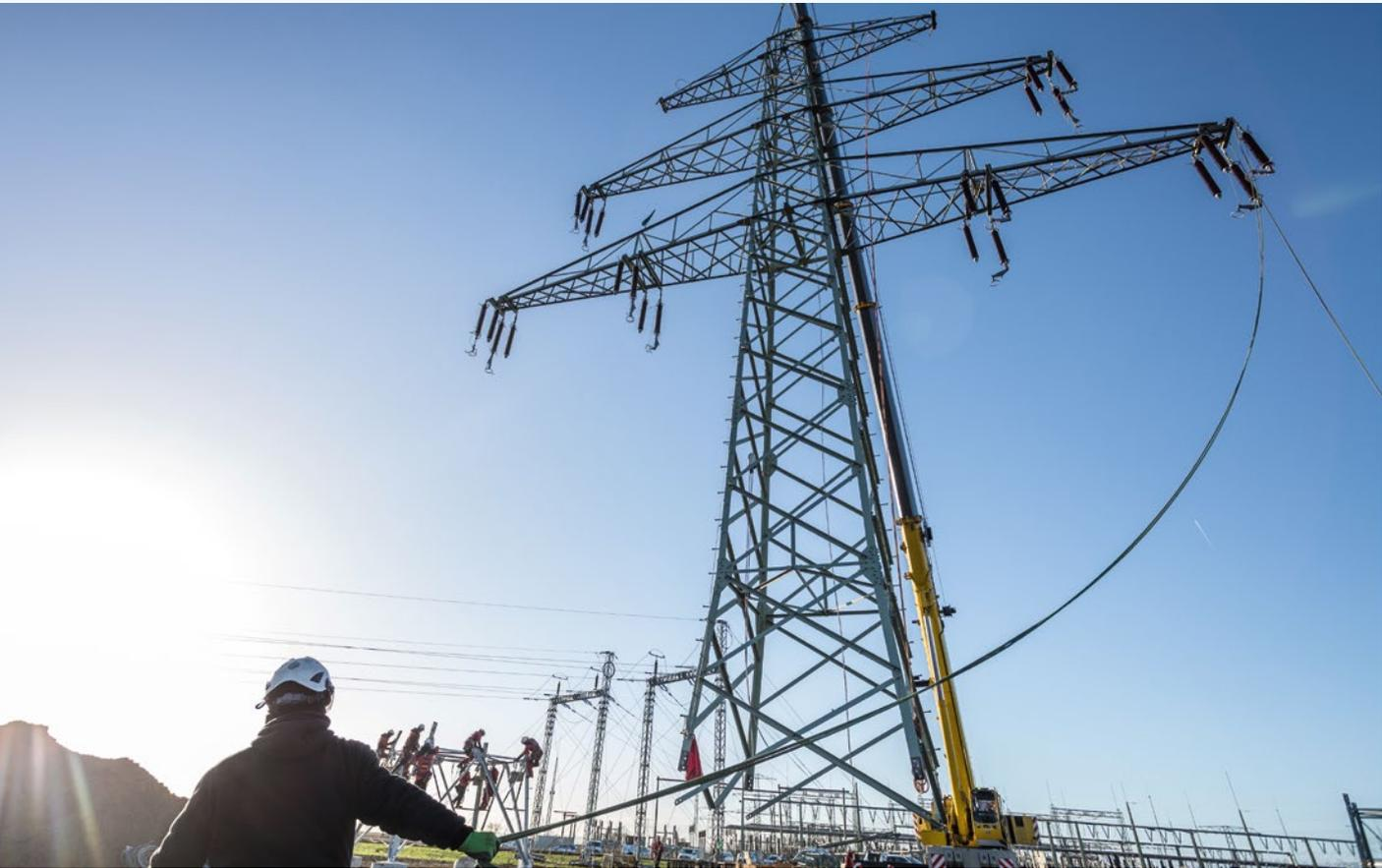
Umsetzung eines Hochspannungsmastes im Umspannwerk Klostermansfeld
