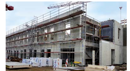
Das siebente Rechenzentrum der envia TEL befindet sich derzeit im Bau.
