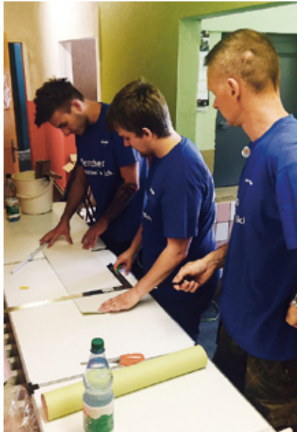
Mitarbeiter der MITNETZ STROM halfen bei der Renovierung der Kindertagesstätte „Sonnenblume“ in Falkenberg/Elster.
