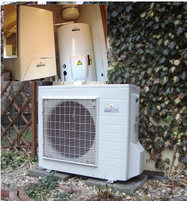
Außen- und Innenansicht einer Wärmepumpe.
