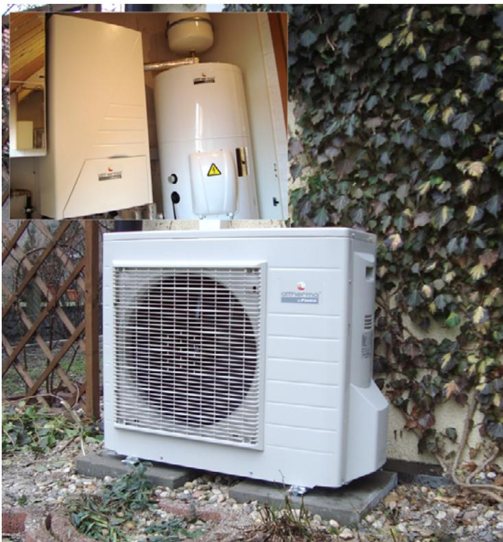
Außen- und Innenansicht einer Wärmepumpe.
