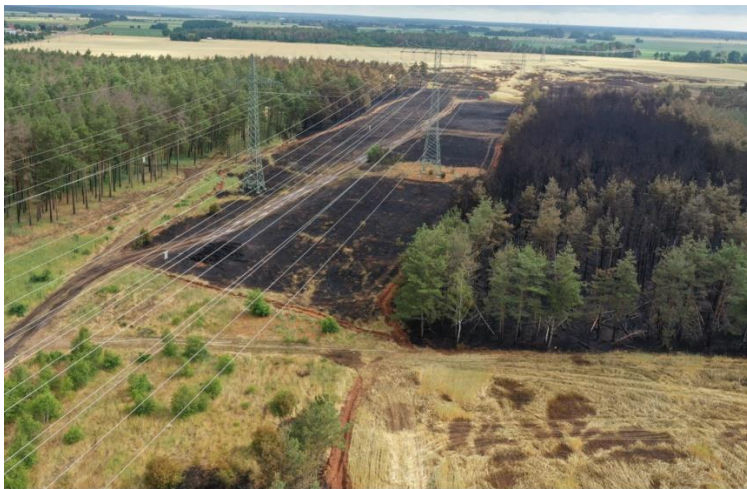
Bildunterschrift: Überprüfung Hochspannungsleitung nach Waldbrand bei Kemberg
