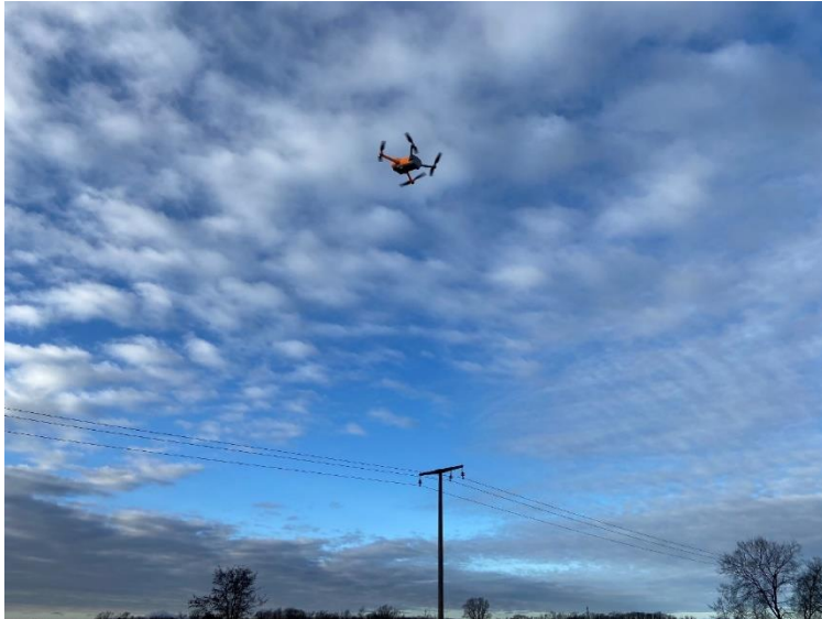
Bildunterschrift: Überprüfung Mittelspannungsfreileitung bei Doberschütz
