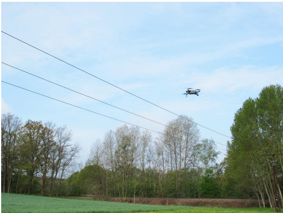
Bildunterschrift: Inspektion an einer Mittelspannungsfreileitung bei Bad Schmiedeberg:
