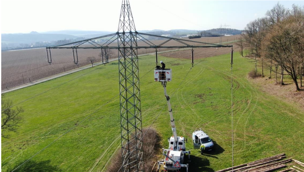
Bildunterschrift: Inspektion an einer Mittelspannungsfreileitung bei Bad Schmiedeberg:
